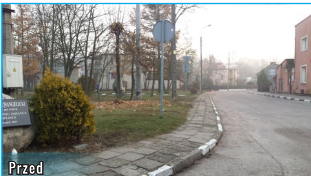
remont chodnika na ulicy Podzamcze
