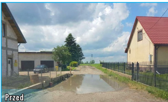
przebudowa drogi w Kiełpinach
