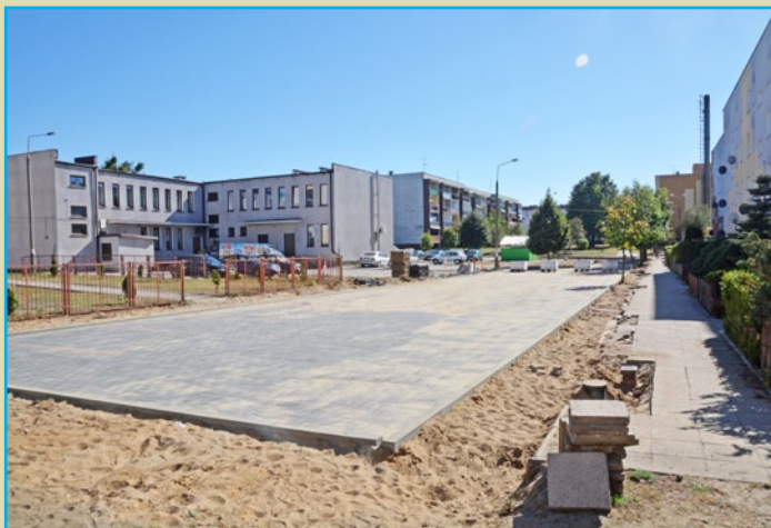
Budowa drogi przy bloku Jeleńska 9
