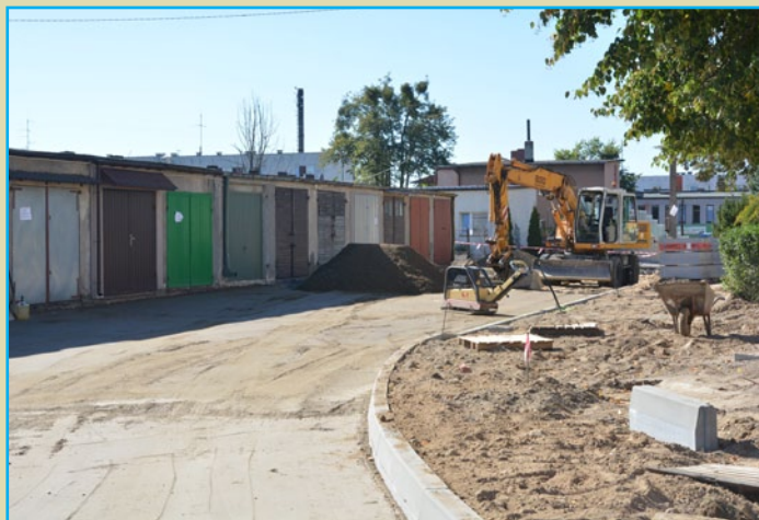
Budowa drogi na ul. Jeleńskiej przy blokach nr 28, 30, 32, 34 i 36
